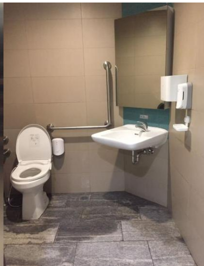
Penyediaan toilet untuk penyandang disabilitas
